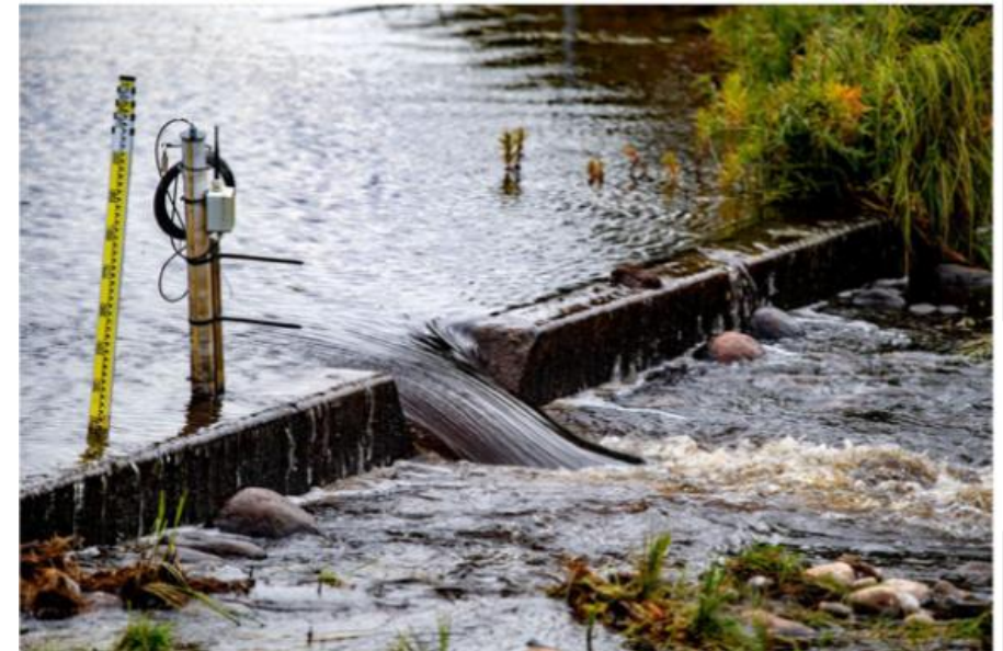
Vedenpinnan korkeutta säännöstellään padolla.
